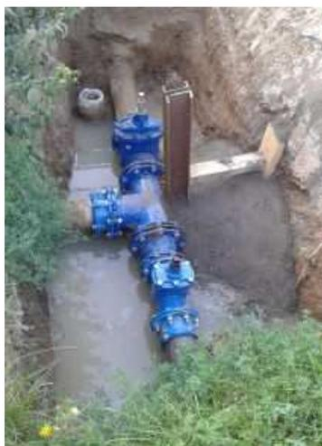
Devant le château d'eau, une vanne défectueuse a dû être remplacée.
