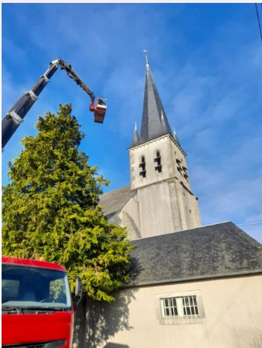
Le 19/12, c'est un bras d'environ 40m qui est intervenu sur la toiture de notre église St Pierre. En effet, plusieurs ardoises du clocher ont dû être remplacées, notamment à cause de l'orage de grêle du 06/09/22,
