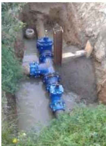
Devant le château d'eau, une vanne défectueuse a du être remplacée.
