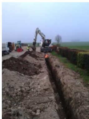
Pose canalisation eau
