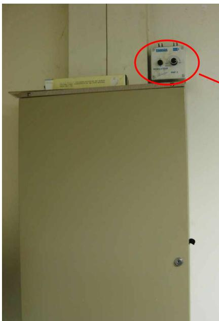
La ventilation motorisée de la salle s'active depuis le boîtier de commande placé au dessus du grand tableau électrique situé dans la cuisine. Positionner d'abord le réglage sur mini puis augmenter jusqu'à la valeur désirée.
