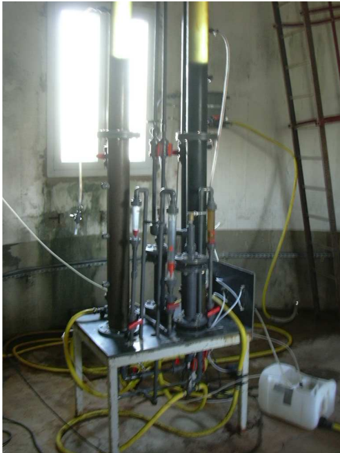
étude pilote réalisée au château d'eau
