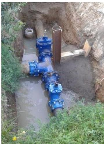
Devant le château d'eau, une vanne défectueuse a dû être remplacée.
